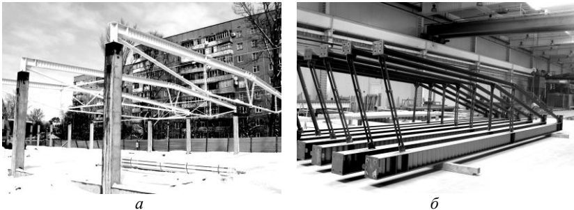
Рис. 4. Малоелементні кроквяні ферми: a – змонтовані ферми покриття; б – відправні одиниці ферм в процесі виготовлення (фото М.В. Лазнюка)
