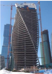
Рис. 1. Будівництво вежі «Еволюція»
